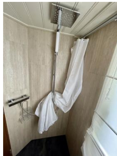
WC Raum Ansicht 2 (Unterdeck)
